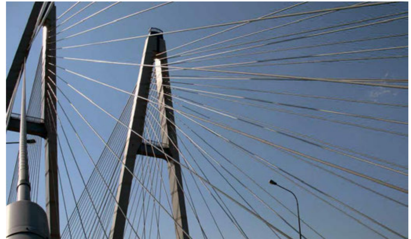
г. Санкт-Петербург, Большой Обуховский мост
